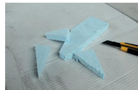
L CON GLI SCARTI RIMASTI FORMARE DEI CUNEI DA INSERIRE TRA AVVOLGIBILE E I PROFILI
