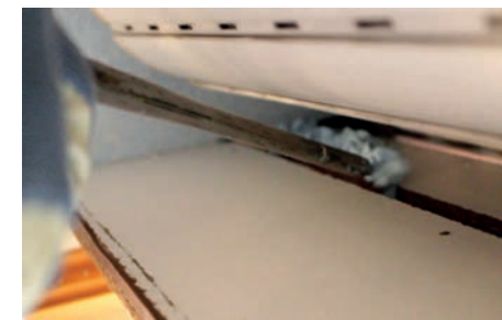
H RIMUOVERE IL PROFILO INFERIORE [4] E SCHIUMARE LA BASE DEL CASSONETTO (PREFERIBILMENTE A TAPPARELLA ABBASSATA)
